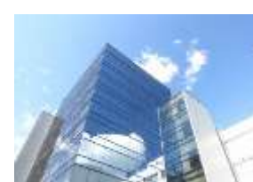
ビルメンテナンス
